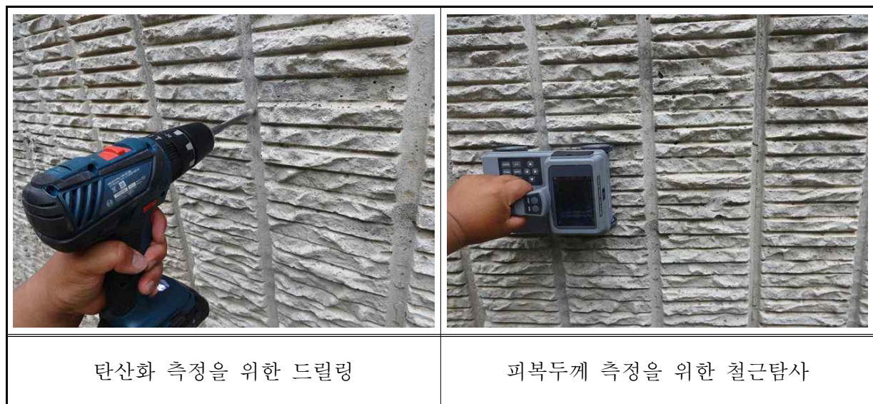
[그림 7.1] 내구성조사 사진
